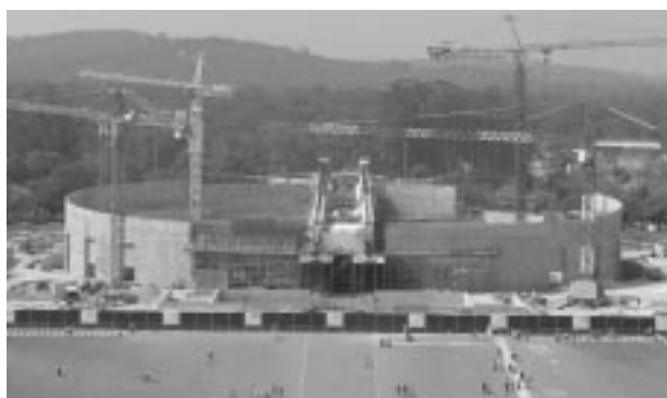
Aspecto actual das obras de construção da Igreja da Santíssima Trindade.
