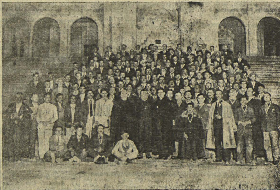
Os operários do Santuário de Nossa Senhora de Fátima em exercícos espirituais. Fotografia tirada às 10 horas e meia da noite no último dia dos exercícos na escadaria em frente da igreja em construção.
