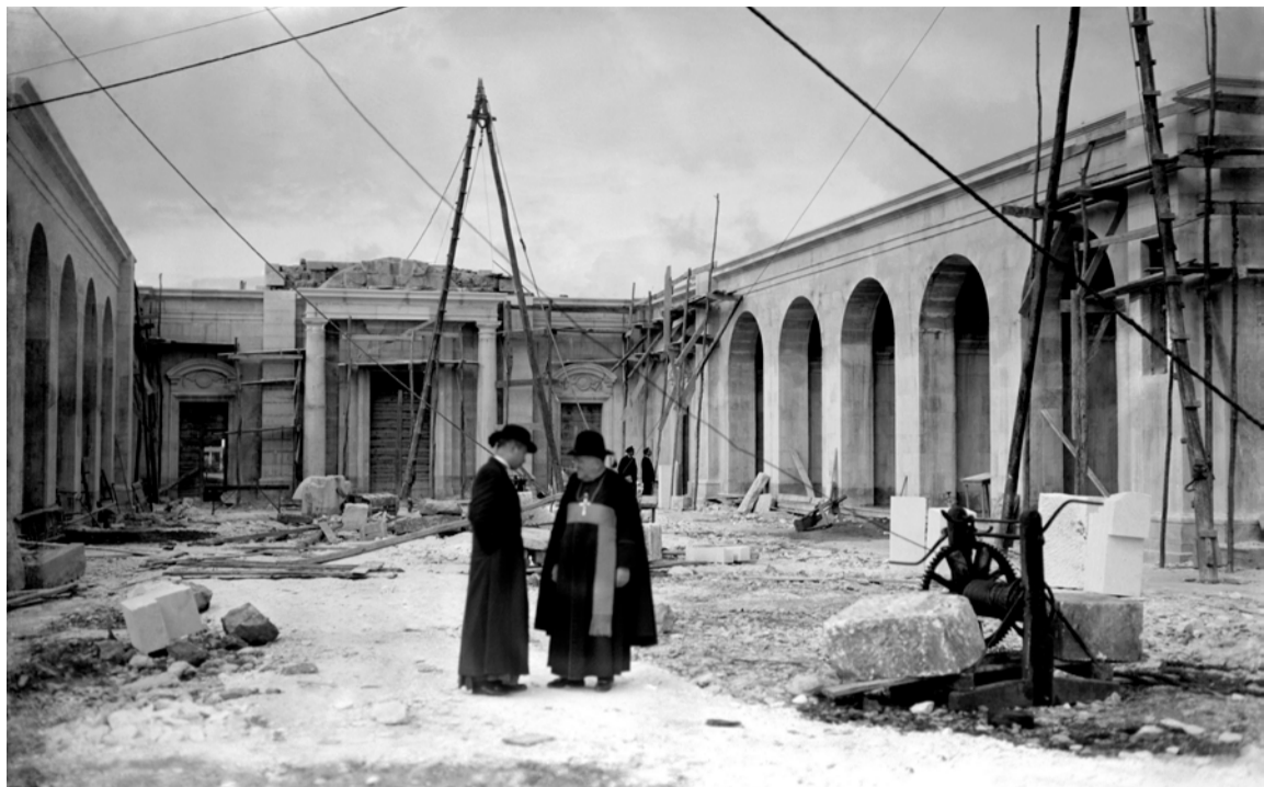
D. José no interior da Basílica em construção, abril de 1933.
