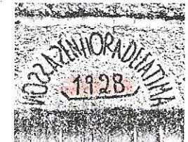
Inscrição com a data da fundação da Capela de Coruche
